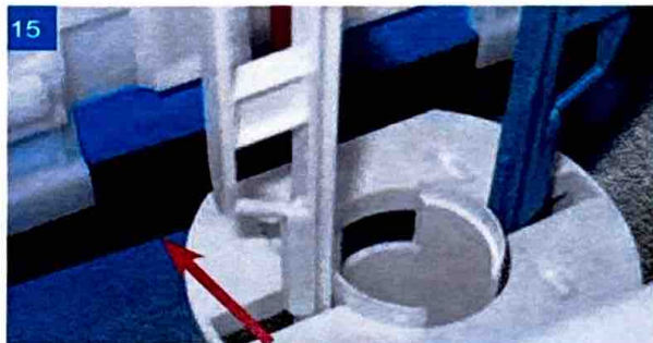
Wasserstand auf Unterkante Spannring
