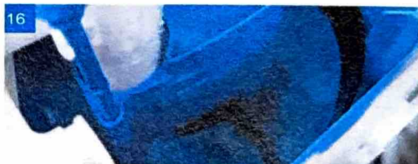
Wasserstand auf Unterkante Spannring
